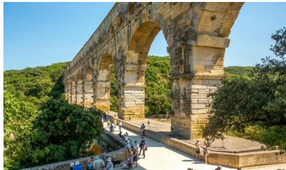
Pont du Gard (detalle pasarela) 2
